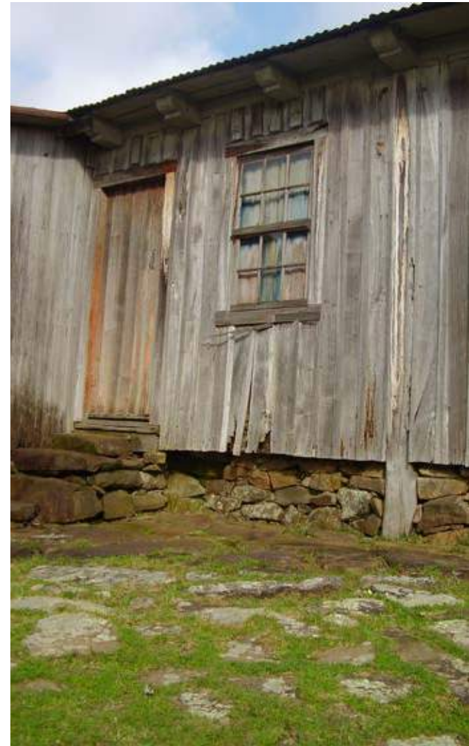
Sede da fazenda Capão do Posto, Capão Alto. Foi propriedade do Coronel Emiliano Ramos, tendo sido construída inteiramente em madeira de araucária por volta de 1870. Vista dos fundos, notando-se os beirais do tipo cachorro e os esteios terminados em “nabos”, que sustentam a estrutura. Foto: autor, 2009.
