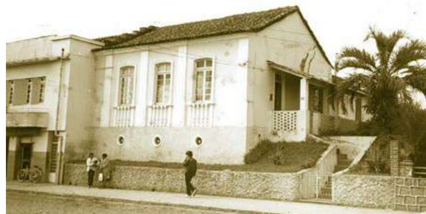
Residência localizada na rua Correia Pinto, Lages. Apresentava recuo e acesso lateral. Acervo: Fundação Cultural de Lages.
