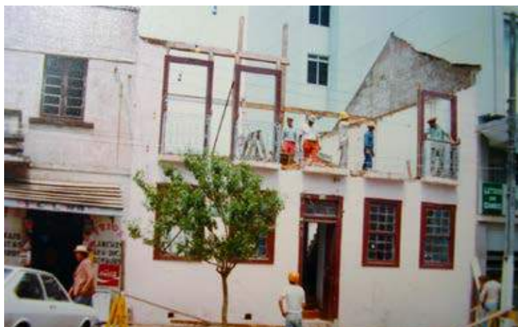
Demolição de um sobrado do século XIX na rua Nereu Ramos, Lages, em 1984. Conjugava alvenaria (pavimento térreo) e pau-a-pique (pavimento superior) na parede frontal. Acervo: Museu Thiago de Castro.
