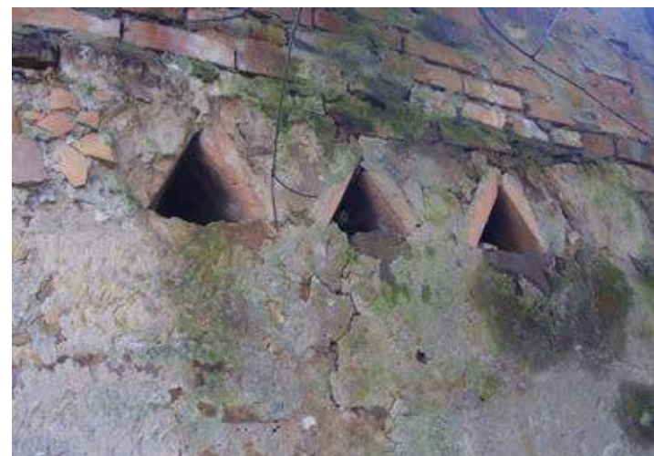
Vestígios de cozinha do século XIX nos fundos de uma moradia da rua Hercílio Luz, Lages (casa de porta e janela do conjunto arquitetônico apresentado na página 164). A existência das três aberturas de formato triangular na parede voltada para o lote vizinho auxiliava na eliminação da fumaça proveniente do preparo dos alimentos. Fotos: autor, 2008.
