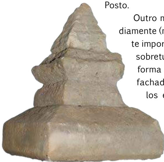
Pináculo em pedra utilizado no arremate do telhado da sede da fazenda Morrinhos, Lages. Foto: autor, 2009.
