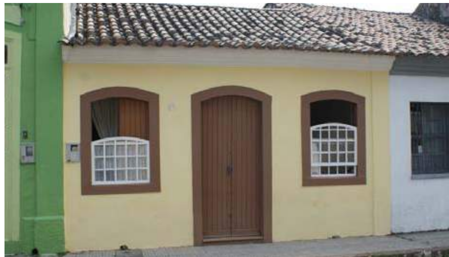
Casa térrea do século XVIII, em Laguna, SC. Foto: autor, 2010.
