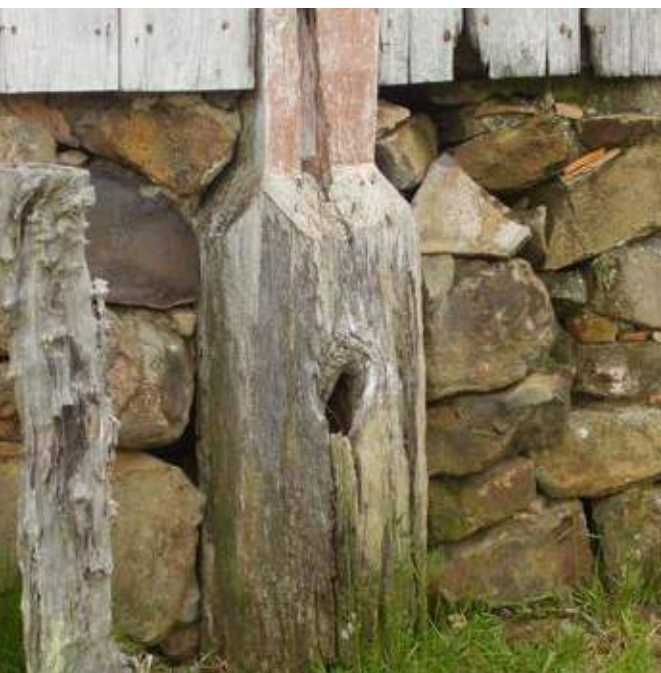
Fazenda Capão do Posto, município de Capão Alto: detalhes dos beirais do tipo cachorro e dos “nabos” dos esteios, que sustentam a construção. Foto: autor, 2009.
