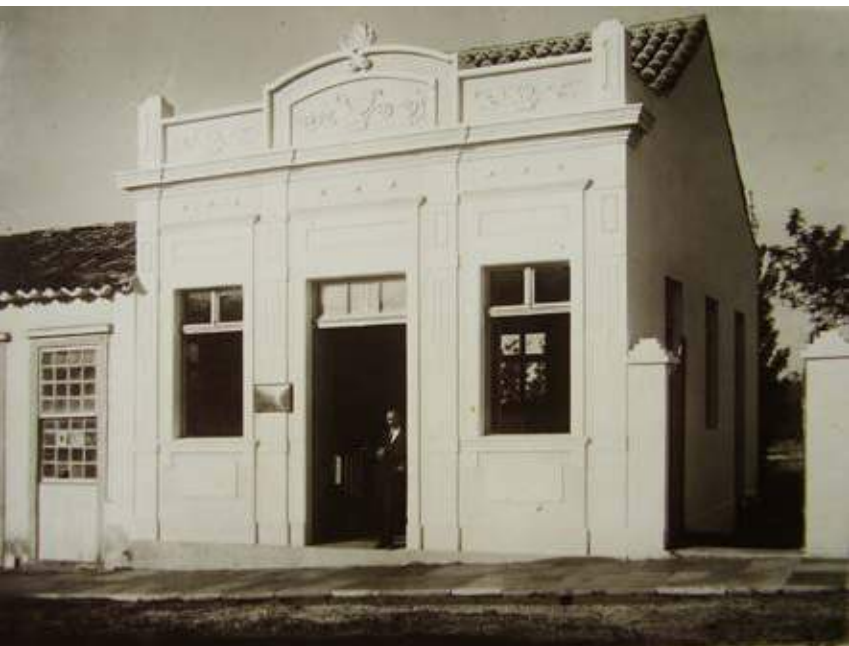
Casa do século XIX, outrora existente na rua Nereu Ramos, Lages. Reformada ao gosto eclético, na década de 1910 passou a ostentar platibanda, conforme determinava a Postura de 1903.
