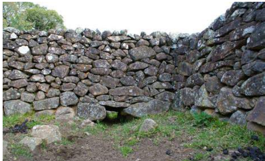
Detalhe de mangueira em taipa de pedra na fazenda São João, Lages. Em destaque, na base do muro, a abertura para drenagem do curral. Foto: autor, 2009.
