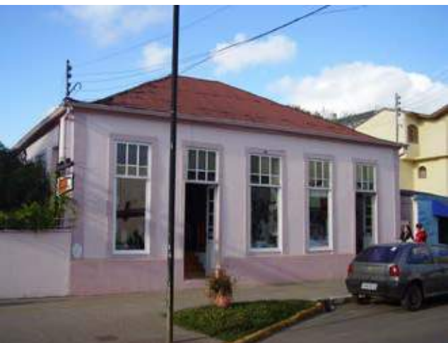
Residência da família Mattos, situada na rua Major Jacinto Goulart, São Joaquim: último exemplar de arquitetura urbana do século XIX no município, foi construída em alvenaria (com exceção da cozinha, nos fundos) e teve as paredes revestidas internamente com madeira, conferindo-lhe importante conforto térmico. Fotos: autor, 2009.
