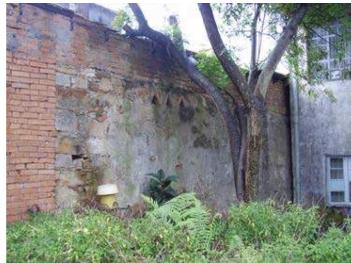
Vestígios de cozinha do século XIX nos fundos de uma moradia da rua Hercílio Luz, Lages (casa de porta e janela do conjunto arquitetônico apresentado na página 164). A existência das três aberturas de formato triangular na parede voltada para o lote vizinho auxiliava na eliminação da fumaça proveniente do preparo dos alimentos. Fotos: autor, 2008.
