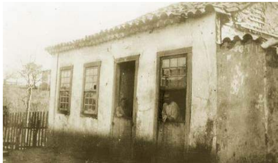
Moradia urbana do século XIX, já desaparecida, apresentava a parede frontal em alvenaria e a lateral em pau-a-pique, Lages. Acervo: Museu Thiago de Castro.
