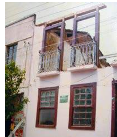
Demolição de um sobrado do século XIX na rua Nereu Ramos, Lages, em 1984. Conjugava alvenaria (pavimento térreo) e pau-a-pique (pavimento superior) na parede frontal. Acervo: Museu Thiago de Castro.
