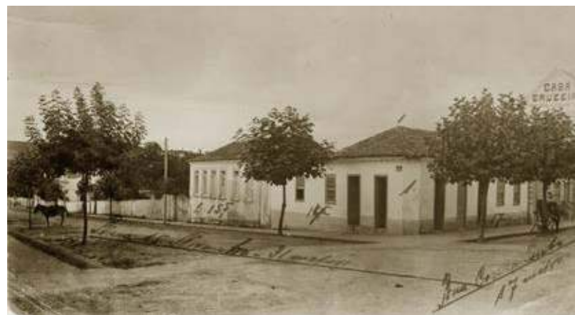
À esquerda, antigo armazém situado na esquina das ruas Correia Pinto e Nereu Ramos, em que se eliminou o cunhal para atendimento da Postura de 1895. Acervo: Jonas Malinverni.
