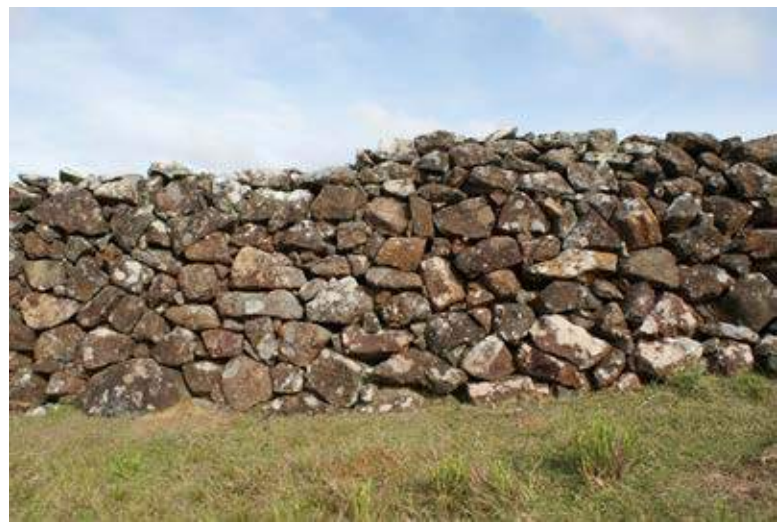
Acima, muro em pedra de junta seca na Ilha Terceira, Açores, Portugal. Em baixo, muro em “taipa de pedra” na fazenda São João, Lages. Notar a forte semelhança entre as estruturas. Fotos: autor, 2008 e 2009.
