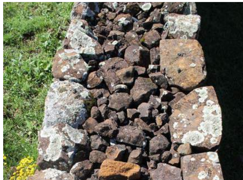
Taapeiro refazendo muro na fazenda da Rata, São Francisco de Paula, RS, e detalhe em que se vê o acabamento da parte superior do muro de taipas de uma mangueira, na fazenda dos Palmas, São Joaquim. Fotos: autor, 2008; 2014.
