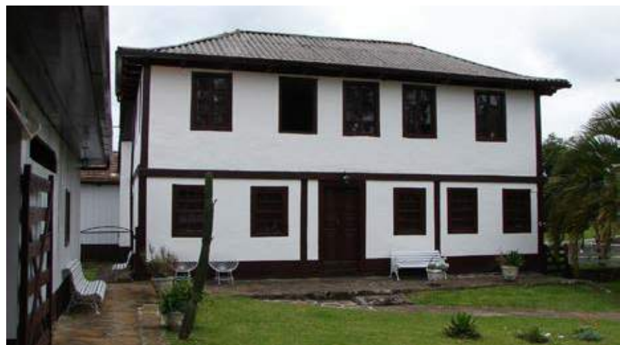
Sede da fazenda Cadete, em Lages, derradeiro exemplar em que se aplicou a técnica do pau-a-pique na feitura das paredes externas. Foto: Nery Auler da Silva, 2008. Acervo: IPHAN-SC.
