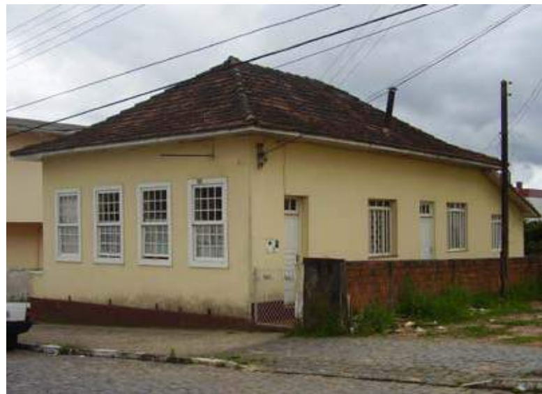
Residência em alvenaria, do final do século XIX, localizada na rua Manoel Thiago de Castro, Lages. Foto: autor, 2008.
