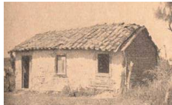
Primitiva casa de pau-a-pique em processo de arruinamento. Foto: Peluso Júnior, 1952.
