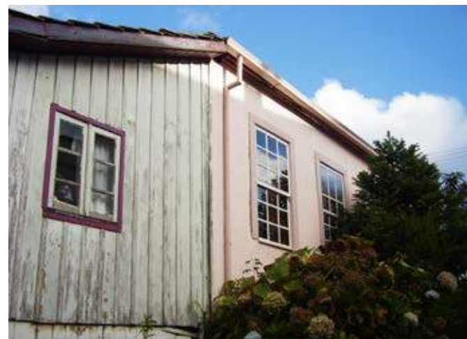
Residência da família Mattos, situada na rua Major Jacinto Goulart, São Joaquim: último exemplar de arquitetura urbana do século XIX no município, foi construída em alvenaria (com exceção da cozinha, nos fundos) e teve as paredes revestidas internamente com madeira, conferindo-lhe importante conforto térmico. Fotos: autor, 2009.
