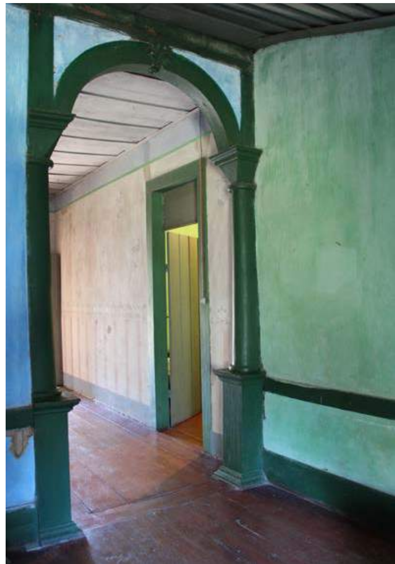
Fazenda Cajuru. Em contraponto à simplicidade e ausência de luxo, características da sede de um estabelecimento pastoril dos Campos de Lages, a presença do imponente arco de acesso à sala de jantar inspira um ar aristocrático na moradia, reforçando sua condição de casa senhorial. Foto: Charles Steuck, 2014.
