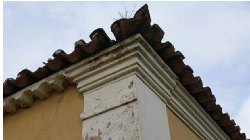
Detalhe da sede da fazenda São João, Lages, onde se nota o tratamento diferenciado entre a fachada frontal, que apresenta cimalha em alvenaria, e a lateral, com beiral em beira-seveira. Foto: autor, 2008.
