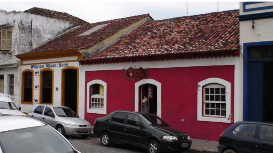
Casas térreas do século XVIII, em São Francisco do Sul, SC. Fonte: autor, 2007.
