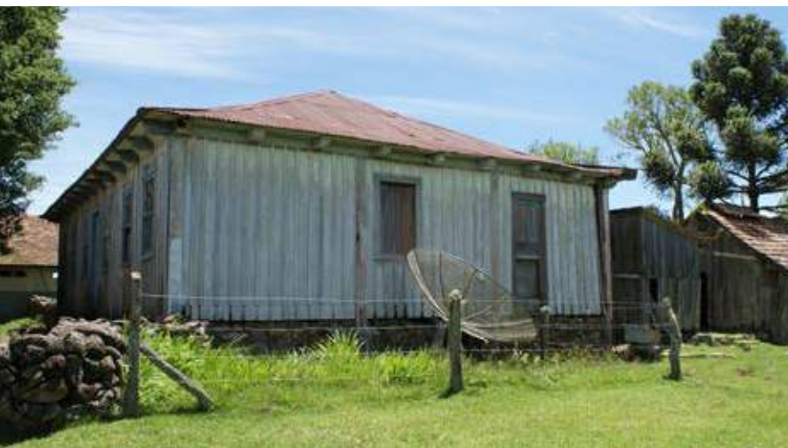
Fazenda Capão do Posto, Capão Alto. Vistas externas, notando-se na fachada lateral direita o local em que havia uma varanda, elemento pouco comum na arquitetura de tradição luso-brasileira da região Sul. Foto: autor, 2009.
