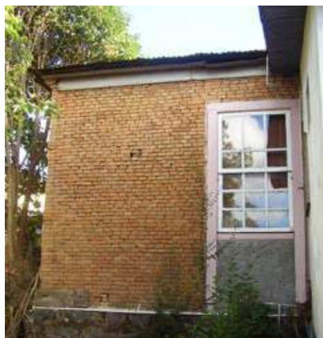
Residência da família Mattos, situada na rua Major Jacinto Goulart, São Joaquim: último exemplar de arquitetura urbana do século XIX no município, foi construída em alvenaria (com exceção da cozinha, nos fundos) e teve as paredes revestidas internamente com madeira, conferindo-lhe importante conforto térmico. Fotos: autor, 2009.
