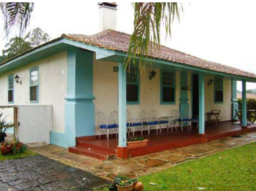
Sede da fazenda Pinheirinho, Lages, erguida no final do século XVIII: fachada enquadrada por robustos cunhais. Foto: autor, 2010.
