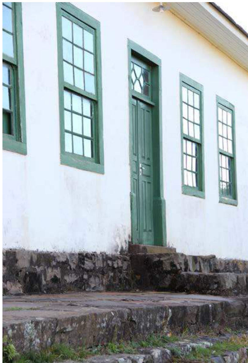
Detalhe da fachada frontal da casa da fazenda Limoeiro, Lages. Construída em alvenaria de pedra na segunda metade do século XIX. Foto: Charles Steuck, 2014.
