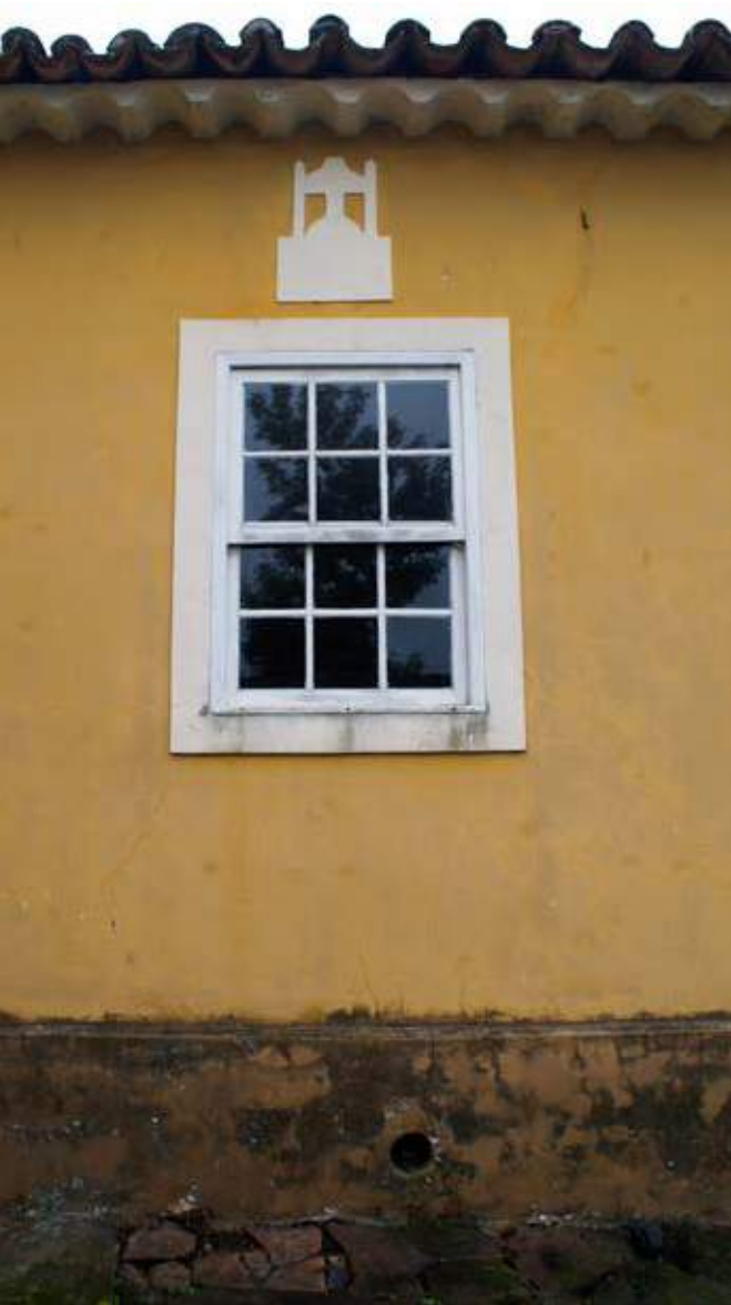
Detalhe de janela da fazenda São João, Lages.
