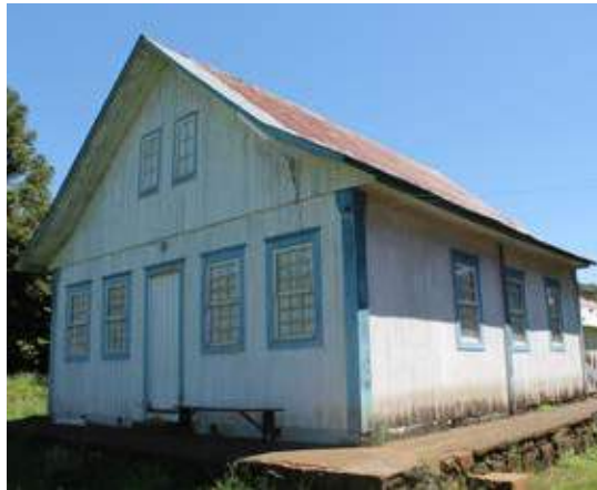
Fazenda dos Palmas, São Joaquim: telhado de duas águas tipo chalet substituiu a cobertura original em quatro águas. Foto: autor, 2015.
