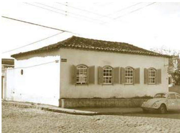
Casa térrea do início do século XIX, na rua Manoel Thiago de Castro, Lages. Está, hoje, bastante descaracterizada. Acervo: Fundação Cultural de Lages.
