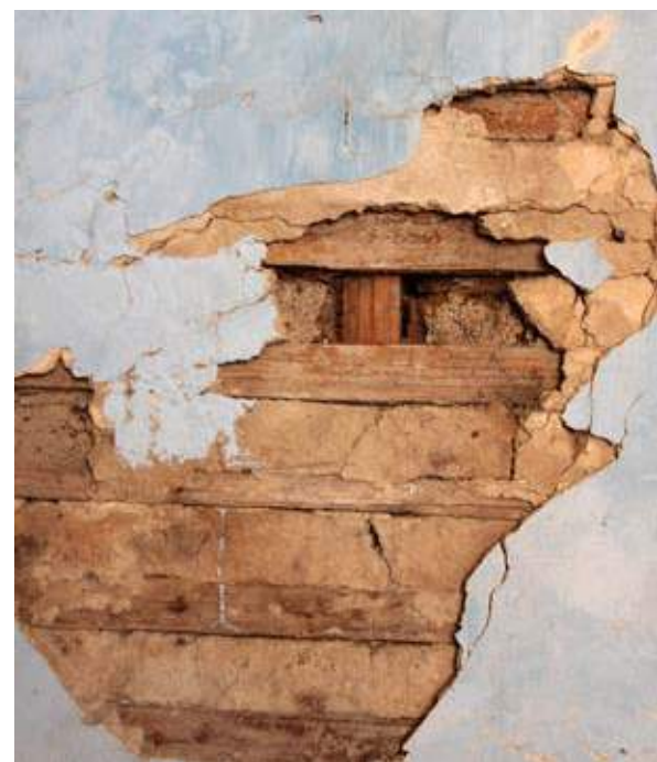
Detalhe de parede em pau-a-pique utilizada como divisória interna na sede da fazenda Cajuru, Lages. Foto: Charles Steuck, 2014.
