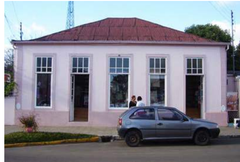
Casa da família Mattos, São Joaquim. Apresenta o enquadramento da fachada frontal mediante a utilização de elementos de caráter compositivo/decorativo, como o embasamento sobressalente, as pilastras/cunhais e a cimbalha. Foto: autor, 2009.
